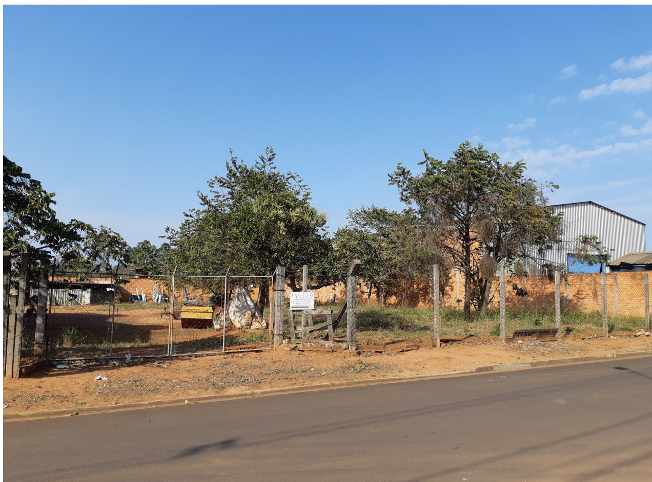
Figura 1: Imagem frontal do imóvel - tirada da Rua Ernesto Cacciolari
