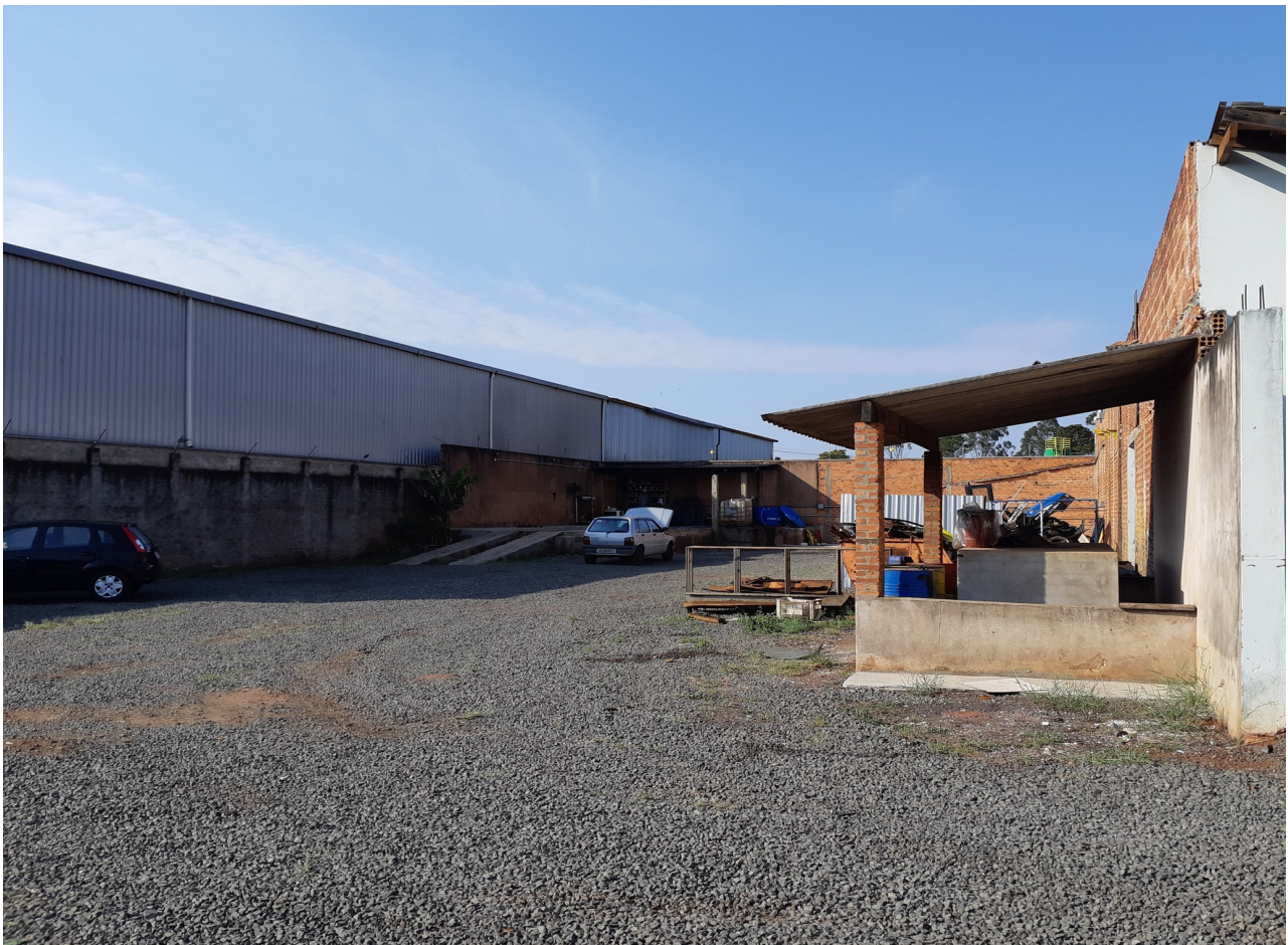
Figura 1: Imagem interna do imóvel (fundos)
